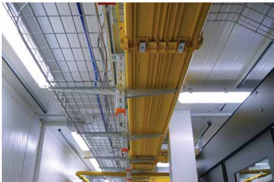
Оптические волокна проложены под потолком модуля в специальных коробах
