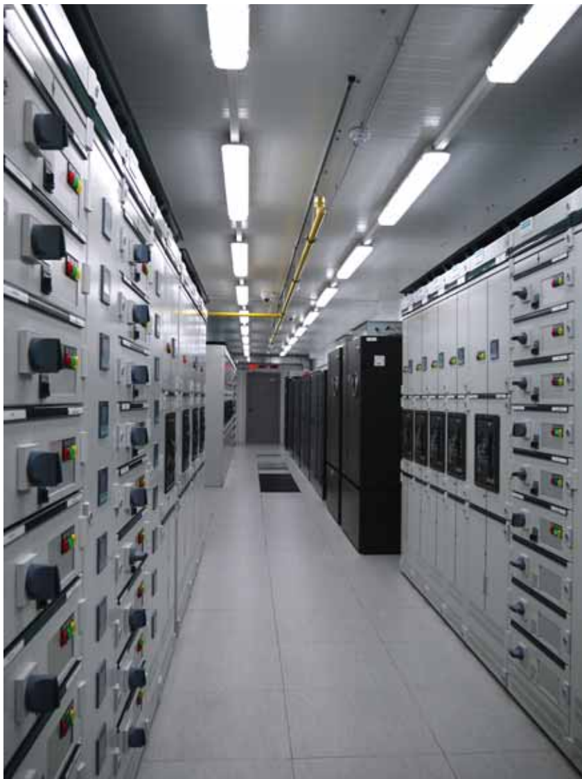
Электропитание модуля обеспечивает дорогостоящее оборудование немецкой компании Siemens
