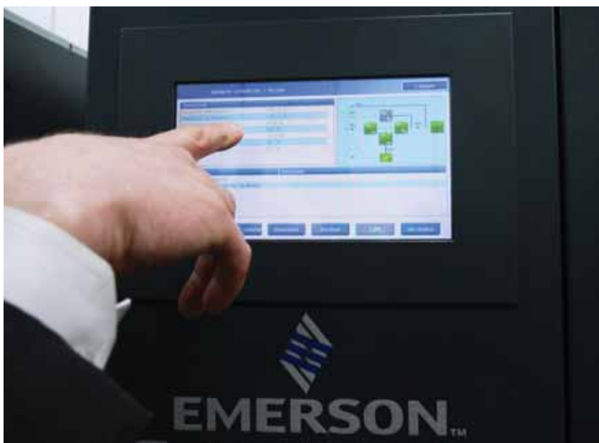
На сенсорных дисплеях генераторов компании Emerson можно посмотреть информацию об уровне выходного напряжения
