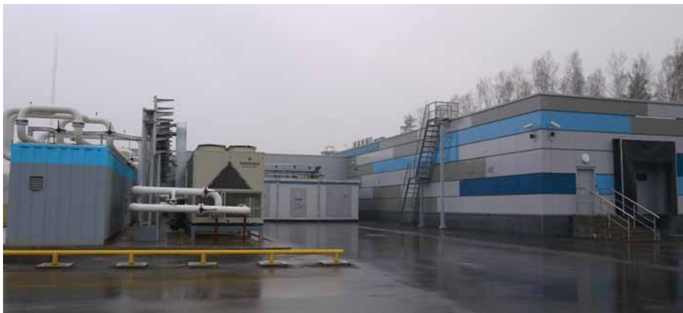
Комплекс состоит из административно-бытового корпуса (в нем также находятся теплые склады), за которым расположено основное здание, где размещены модули ЦОД
